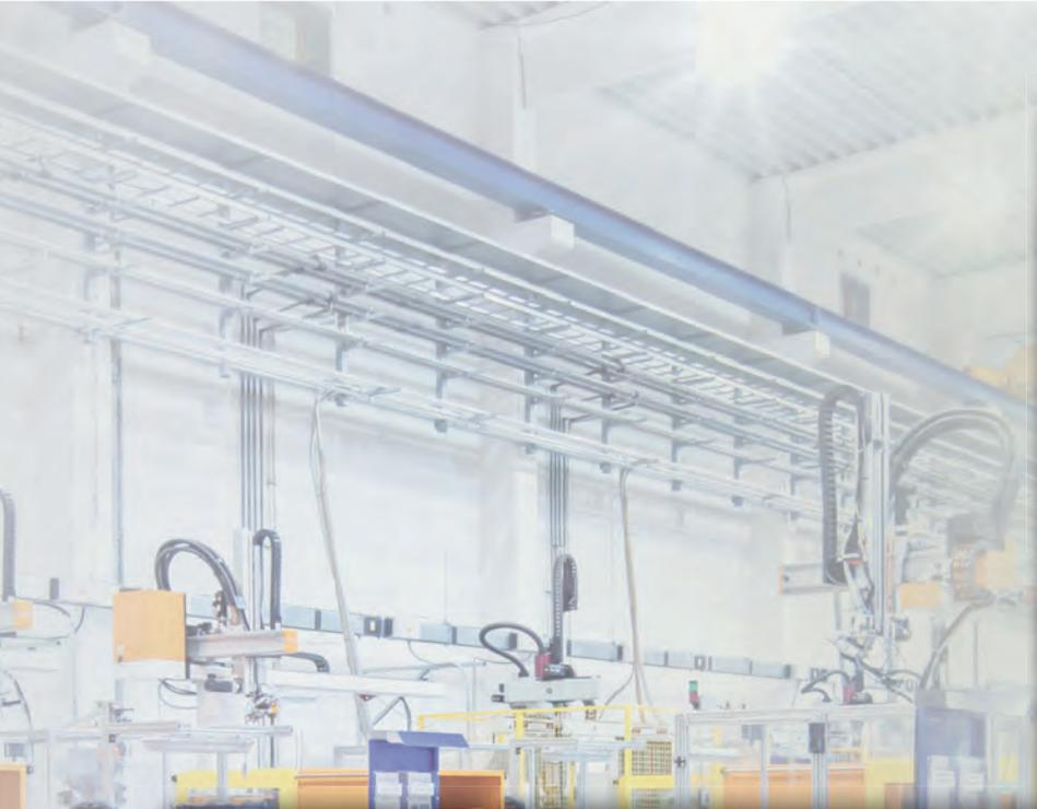
Das Steigetrassen-System lässt sich mittels Dübel ohne Zubehör direkt befestigen und weist zudem die gleichen Vorteile wie das Kabelleiter-System auf: Hohe Tragfähigkeit durch die Holmform, stufen- und bohrlose Verschraubung der Wandanschlussteile dank durchgehender Seitenholmlochung, Schnellbefestigung der zu spannenden Elemente mittels Bügelschellen auf den C-Profilsprossen.
